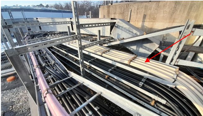
Abb. 3 Kabel auf Kabelpritsche Trafofeld
