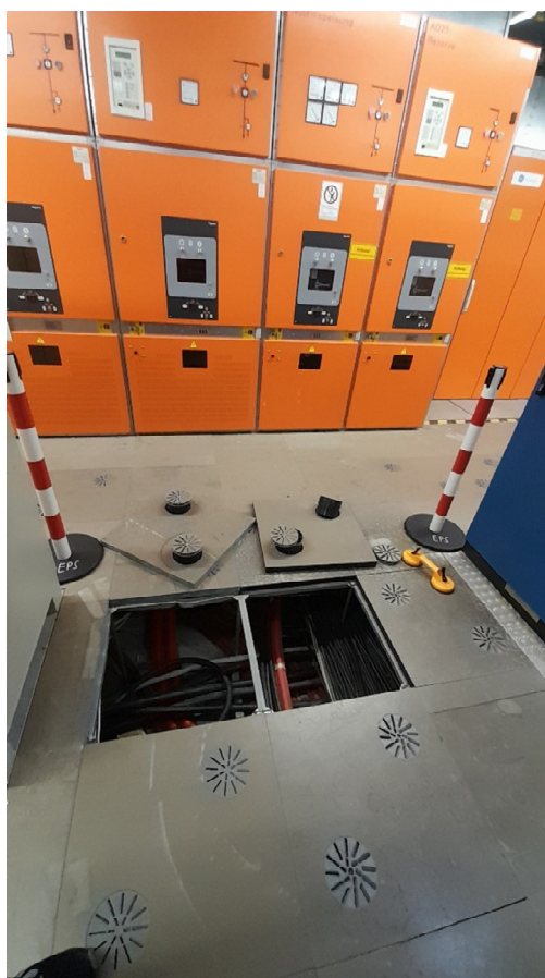
Abb. 10 Doppelboden EG, Kabel zu 20kV Schaltanlage
