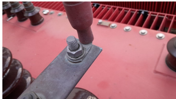
Abb. 15 Anschluss mit Winkelkabelschuh
