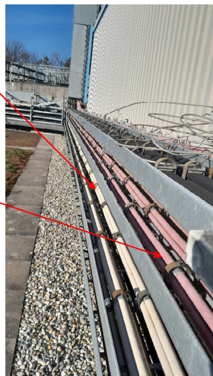
Abb. 21 Kabel auf Kabelpritsche Gebäudeaußenwand
