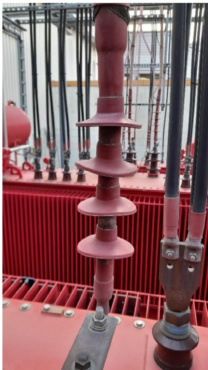
Abb. 14 Kabelanschluss Trafo
