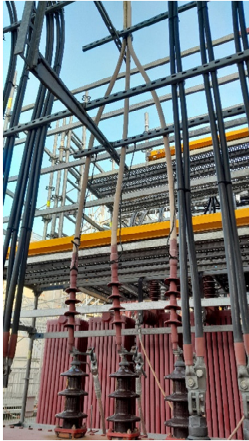
Abb. 2 Transformatoren, Kabel zur Kabelpritsche Trafofeld
