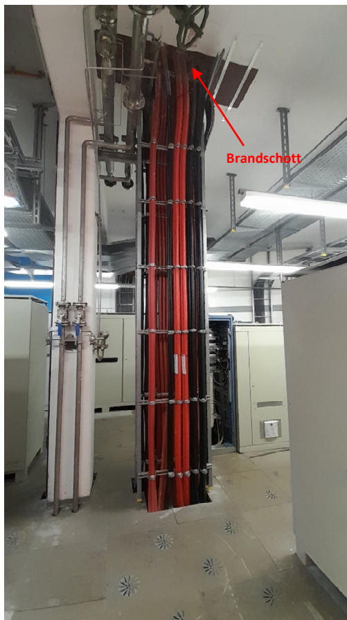
Abb. 8 Steigetrasse, Brandschott im EG, oben
