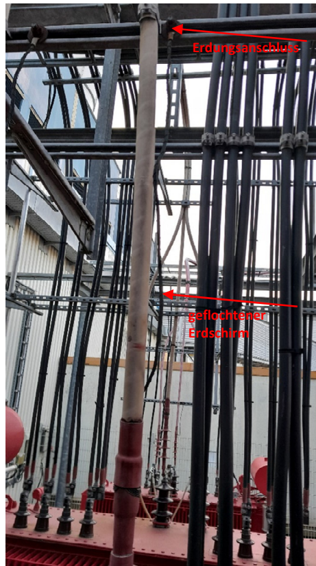
Abb. 16 Erdschirm mit Erdungspunkt
