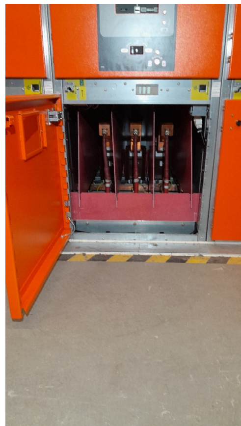
Abb. 12 Kabelanschlüsse in Schaltzelle
