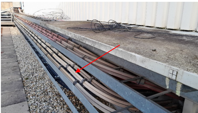
Abb. 4 Kabel auf Kabelpritsche Gebäude Außenwand
