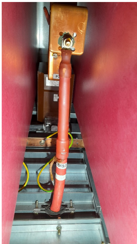
Abb. 13 Kabelanschluss mit Erdungsanschluss
